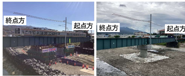
(a) 応急復旧工 (b) 本復旧工
