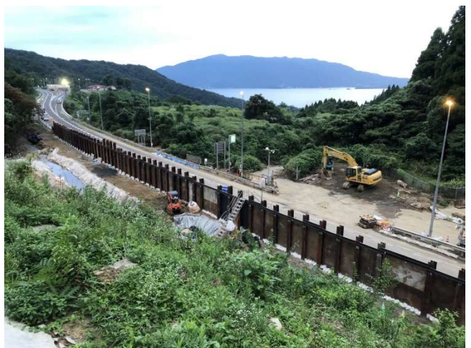
写真-3 下り線敦賀トンネル南坑口応急復旧完了
