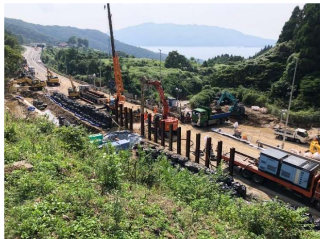
写真-2 下り線敦賀トンネル南坑口応急復旧状況
