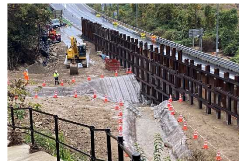
写真-3 透過型土砂防護柵の設置状況
