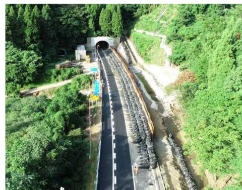
写真-2 下り線応急復旧状況 (通行止め解除時)
