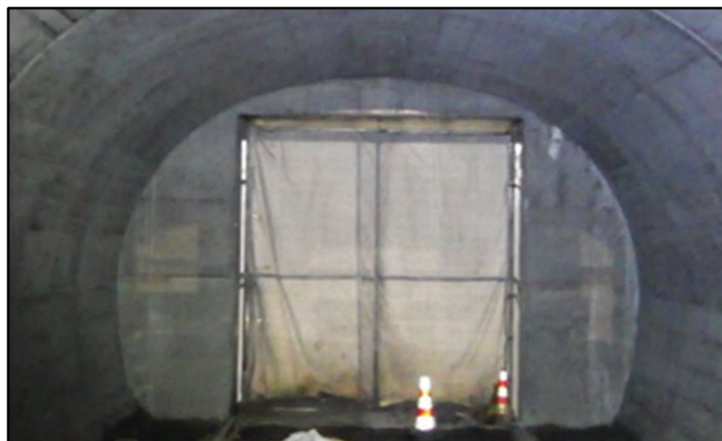
写真-2 補強工の完成状況
