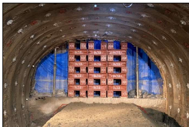
写真-1 サンドルによる山留材での補強（上り線側）
