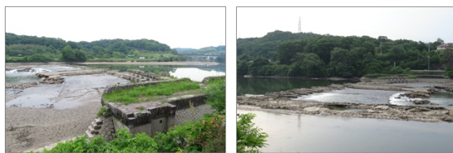
図-1 全貌が露わになった旧明治用水頭首工遺構(2022/5/20) 左:左岸側より(手前は舟通し閘門)・右:右岸側より(手前は導水堤と導水路)
