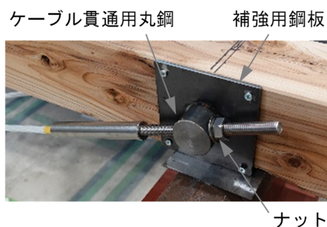
図-2 支点部におけるケーブル結合部の状況
