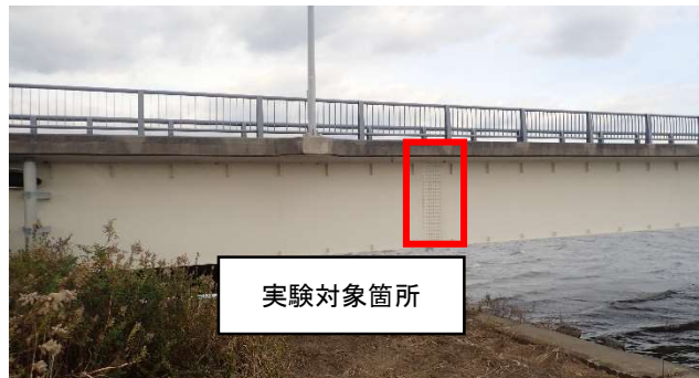
写真-1 六条潟大橋
