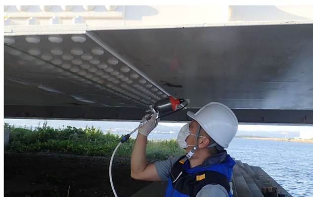
写真-3 シリコーンの吹き付け塗布の様子
