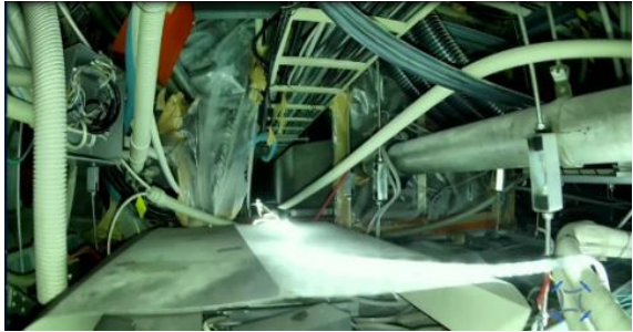
写真-2 天井裏の状況
