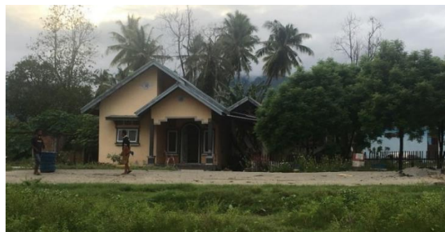
写真-1 流動後の家屋の様子
