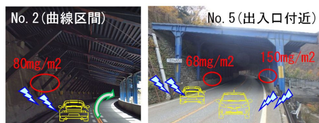
写真-3 塩分付着量(走行車両の水跳ねの影響)
