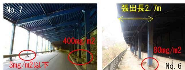
写真-2 塩分付着量(頂版張出しの影響)
