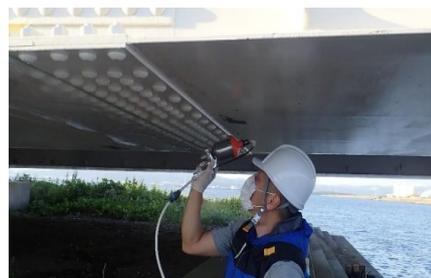
写真-3 シリコンの吹き付け塗布の様子
