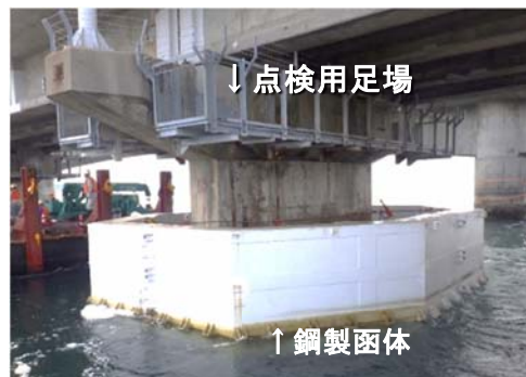
図-3 仮締切(鋼製函体)
