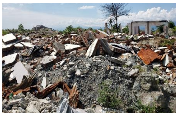
写真-1 地盤流動後の様子 (Balaroa 地区)
