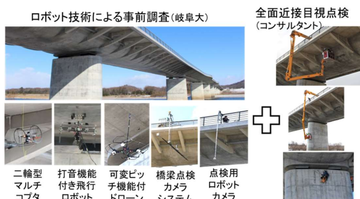
図-1 各務原大橋の定期点検へのロボット技術の活用
