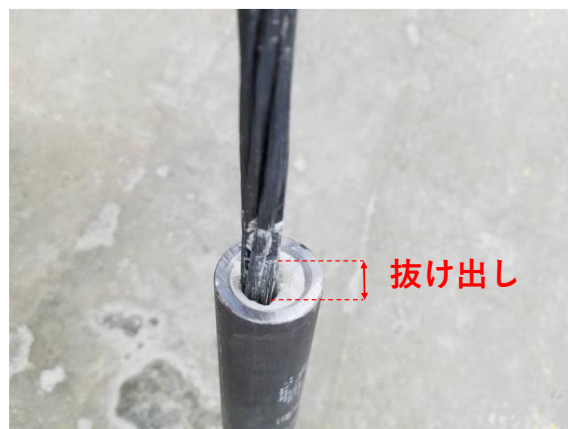
図3 実験終了後の定着部の抜け出し状況
