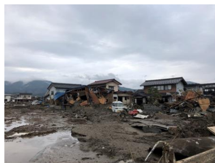
図-2 被災状況（10/27 撮影）
