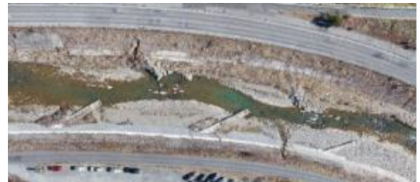
図4 村井工区の空撮画像 (2019年1月撮影)
