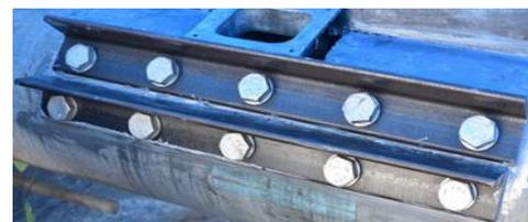
図-6 当て板補強設置図
