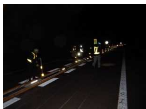
写真-4 中間支柱建て込み
