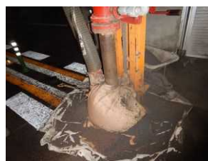
写真-2 削孔状況
