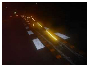
写真-5 ケーブル設置状況
