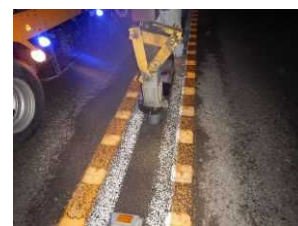
写真-3 鋼管打込状況
