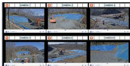
図5 定点での施工状況比較
