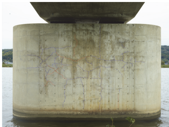
図-1 撮影対象部位の近接目視点検の結果
