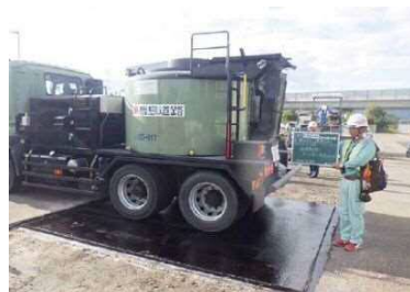
写真-3 乗入れ試験の全景
