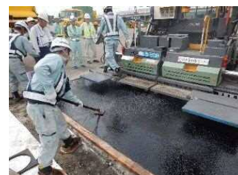
写真-2 新型グースの舗設状況
