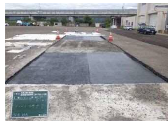
写真-1 模擬床版の全景
