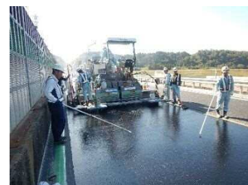
写真-4 本施工実施状況
