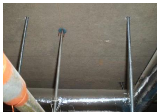
写真-1 天井に設置されたアンカーボルト
