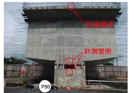
写真-6 自動追尾 TS による計測箇所
