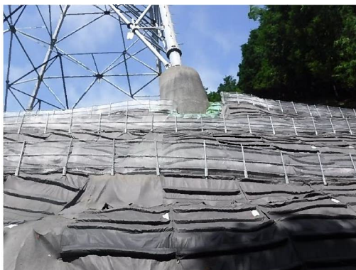
写真2 RLマットによる斜面浸食対策工
