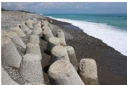
写真-1 七里御浜井田海岸における消波ブロックの様子
