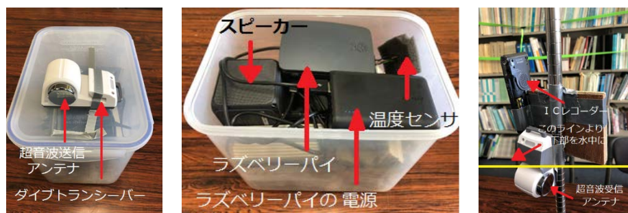
図-1 多項目計測を指向した計測の機器構成 (左: 送信側 (センサー) の外観, 中: 送信側の内部, 右: 受信側の機器)
