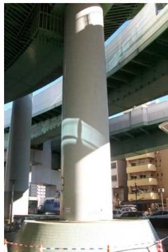
写真-1 対象橋脚
