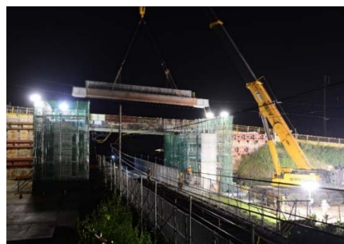
写真-1. 主桁パネル架設状況
