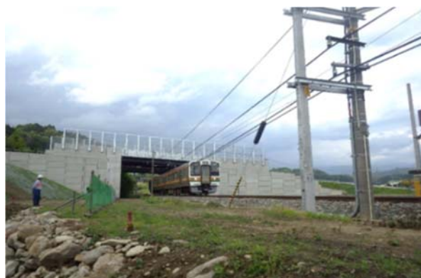
写真-3. 新設した下平跨線橋
