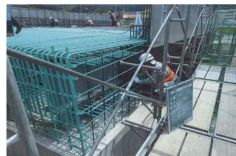
写真-2. 隅角部の配筋状況
