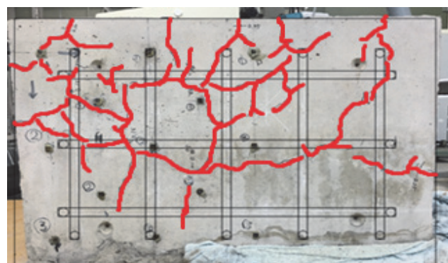
図-2 RC 壁供試体のひび割れ状況 (材齢 1215 日)
