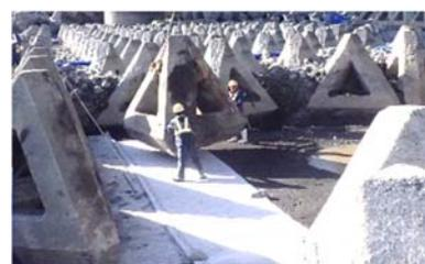
図-2 吸出し防止材敷設状況
