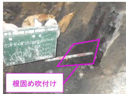
写真-6 根固め吹付け
