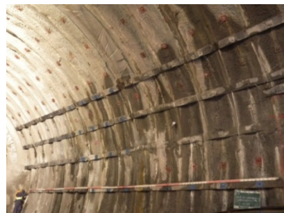
写真-7 補強プレート 補強ロックボルト実施状況
