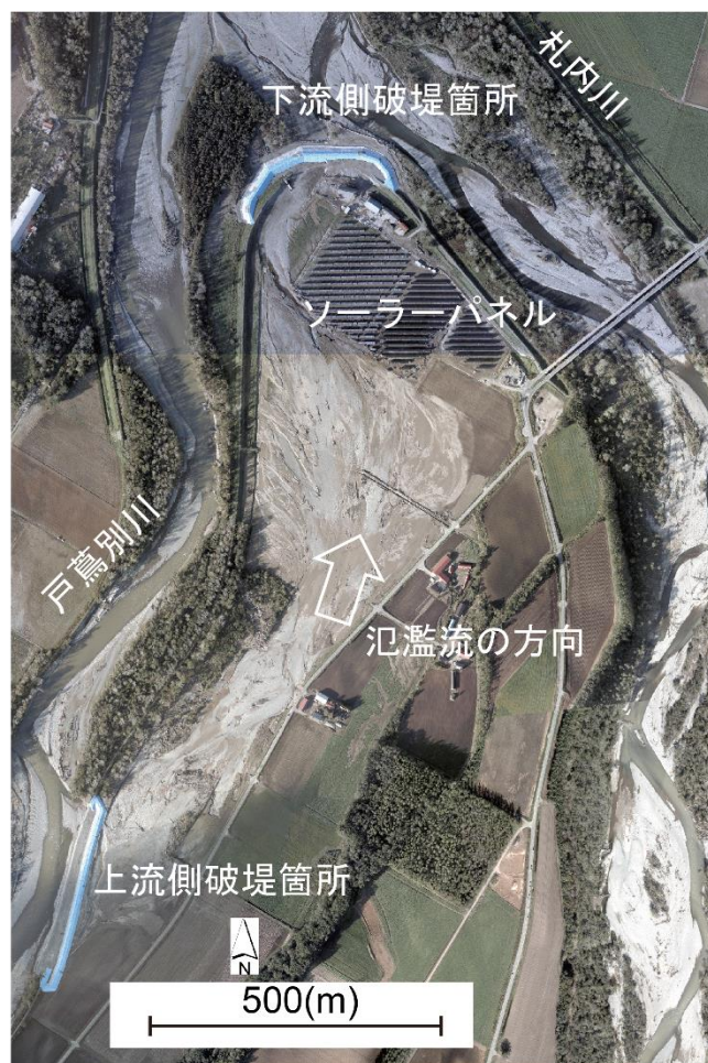
図-1 札内川・戸蔦別川合流点での 2016 年 8 月北海道豪雨災害後の被災状況
