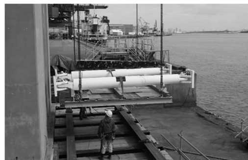
図一 2 ダンパー吊上状況
