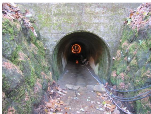
写真 1 トンネル坑口
