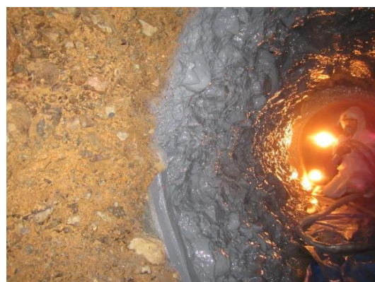
写真 2 施工前後の壁面
