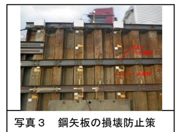
写真 3 鋼矢板の損壊防止策
