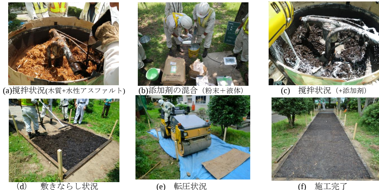
写真-2 施行手順 (写真は 2011 年 7 月 6 日岐阜高専中庭)
