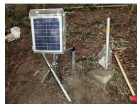
写真-2 設置状況
