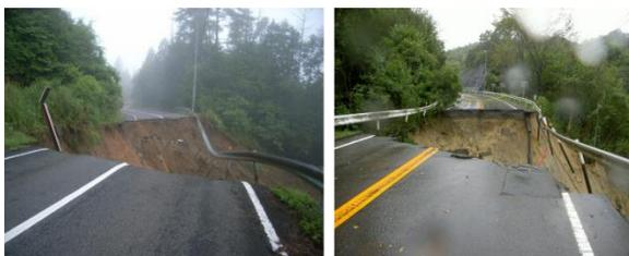
写真1 豪雨により崩壊した道路盛土
