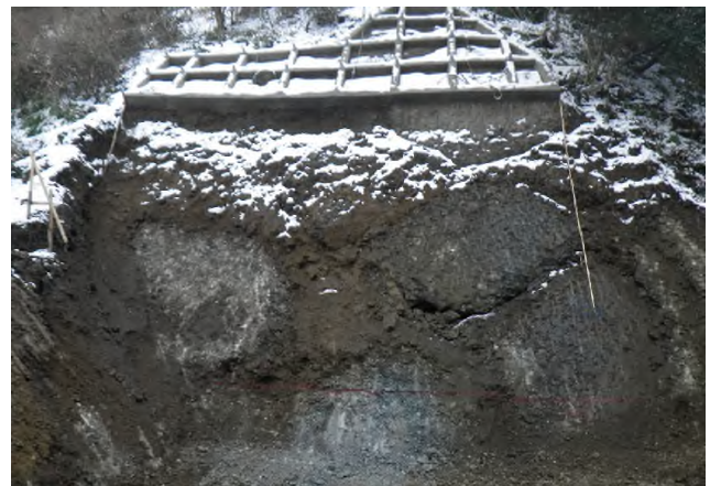
図-2 坑口部のブロック化した礫岩
