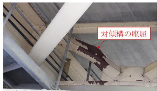
図-3 大規模地震において損傷した対傾構
