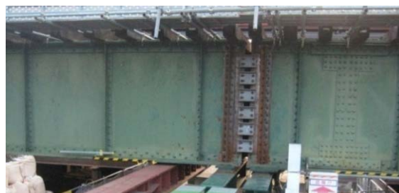
図-6 桁切断完了状況
