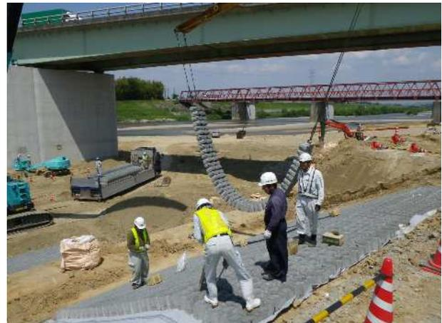
写真-3 JMB による法面保護工の施工状況
