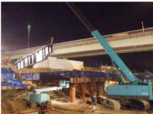
写真-2 作業構台撤去状況(夜間)
