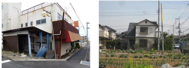
写真-1 戸建て住宅の液状化被害(傾斜・沈下)
