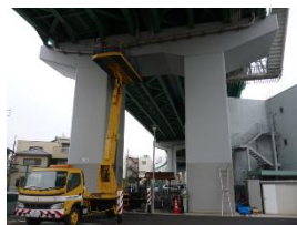
写真-2 橋脚B・東面
