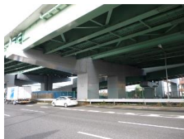
写真-1 橋脚A・東面
