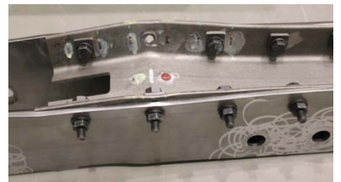
写真 3 拘束部材の破壊状況
