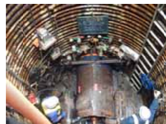
写真 - 1 施工状況
