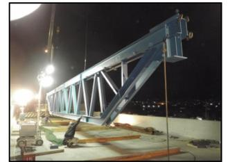
写真-2 トラス梁引き上げ状況
