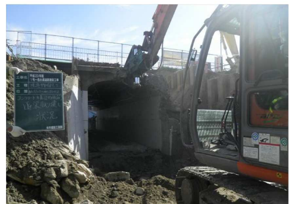
写真-4 コンクリート圧砕機での取壊し
