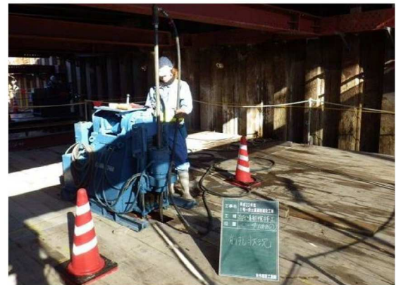
写真-3 高圧噴射攪拌工
