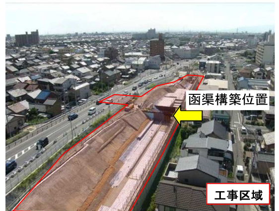
写真-2 工事区域の全景
