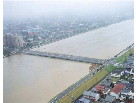
写真-1 東海豪雨時の一色大橋（架替前）
