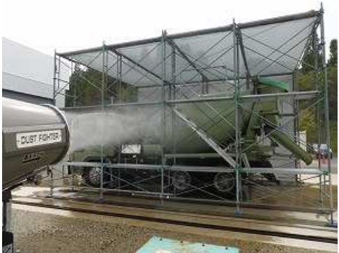
写真-1 散水養生状況
